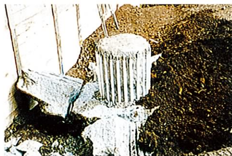
水平・被りコンクリート破断工法(中割)
