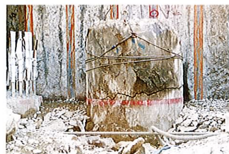
水平破断工法(大割)
