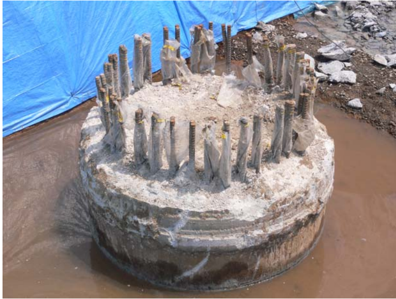
杭頭処理前状況
